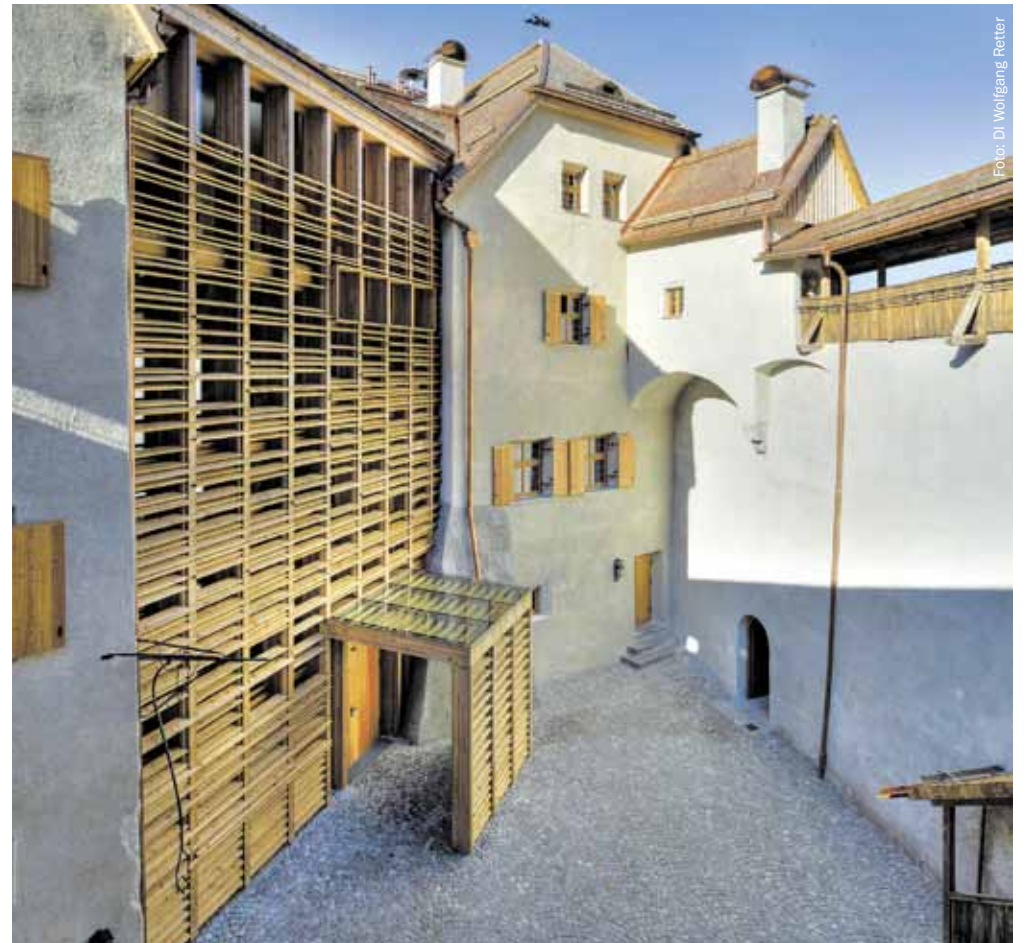
Schloss Lengberg in Nikolsdorf/Osttirol: Die auf das 12. Jahrhundert zurückgehende Anlage wurde mittels sensibler Eingriffe sowohl energetisch an die heutigen Standards herangeführt als auch barrierefrei erschlossen. Bestand und Neubau verbindet sich zu einer von Qualität getragenen baulichen Symbiose. (Wehdorn Architekten ZT GmbH)
